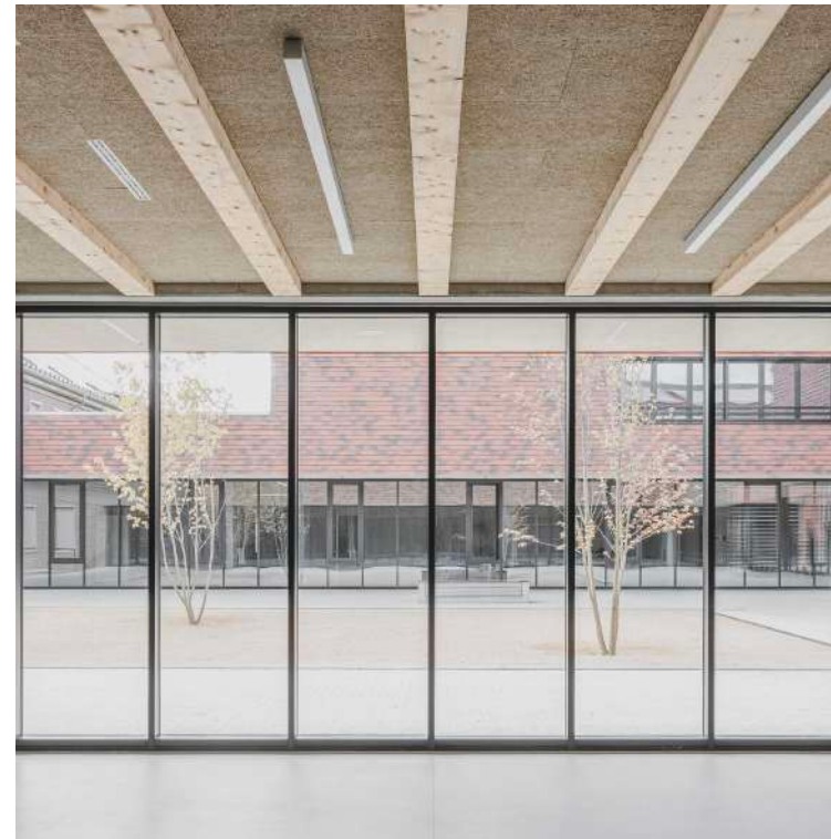
Rippen sichtbar (Unterrichtsraum)
