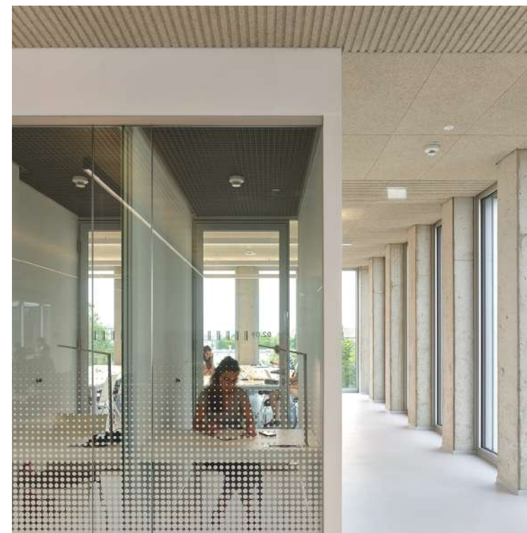
Rippen unsichtbar (Foyer und Flure)
