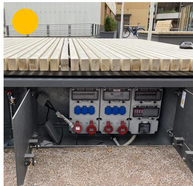
Stromentnahmestelle im Holzdeck @faktorgruen
