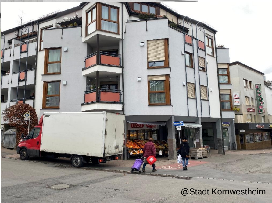
Karlstraße, Marketim Anlieferung Bestand
